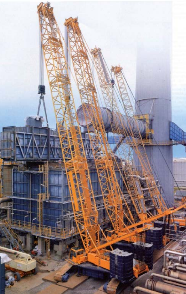
Bild 6-1: Zusammenarbeit von vier Kranen
