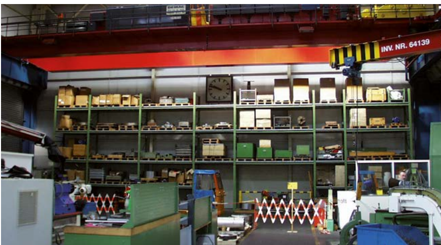
Bild 9-1: Der Gefahrenbereich unter dem Kran ist durch ein rot-weißes Gitter abgesperrt
