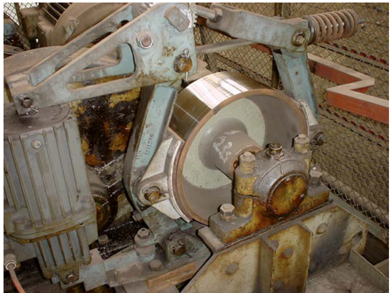
Bild 4-4: Inaugenscheinnahme einer Trommelbremse
