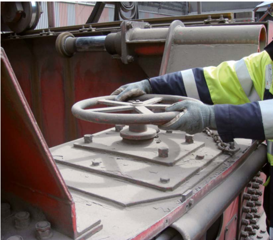
Bild 7-5: Der Kran- führer dreht die Schienenzange an. Diese Windsicherung kann an jeder Stelle der Kranbahn betätigt werden
