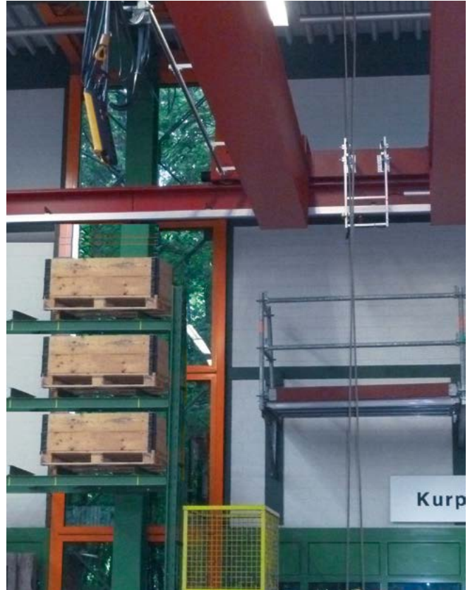
Bild 4-8: Die im Regal gelagerten Kisten ragen in den Verkehrsbereich des Kranes. Der Sicherheitsabstand nach unten von 0,5 m ist nicht eingehalten
