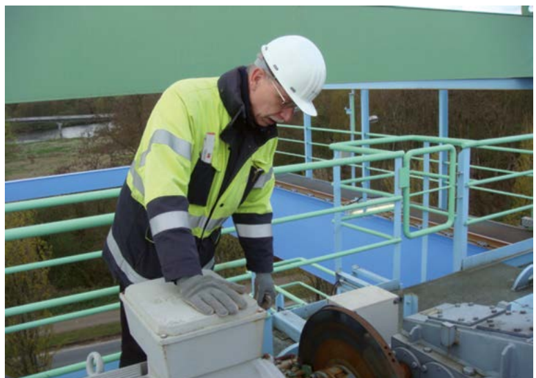
Bild 4-6: Der Kranführer nimmt die Bremse in Augenschein
