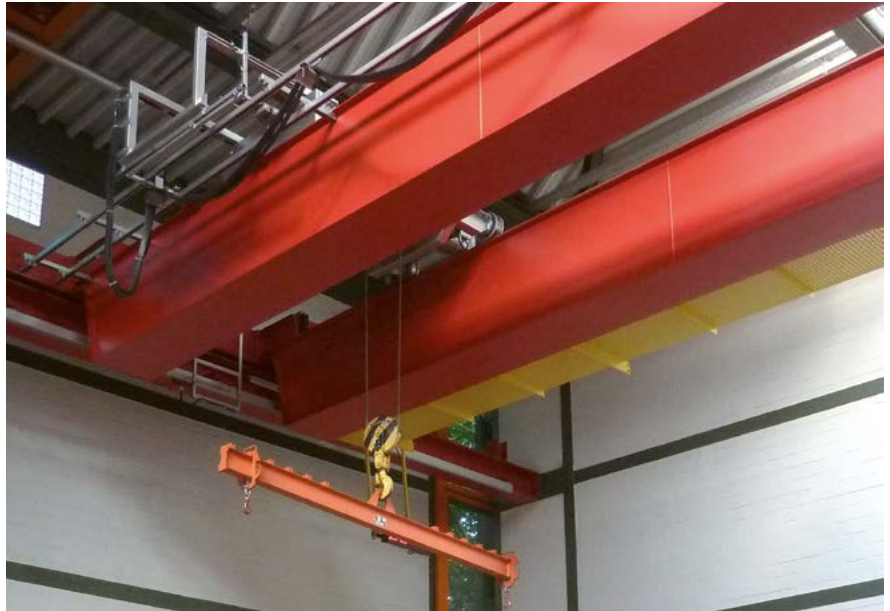
Bild 7-1: Der Kran ist an das Hallenende gefahren, die Traverse ist hochgezogen
